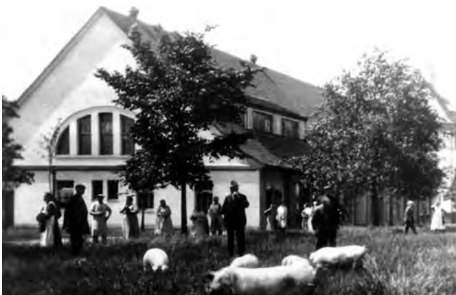
Schweineauslauf vor der Zentralküche
